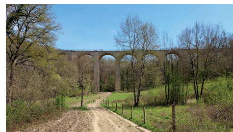
Viaduc des Fauvettes
